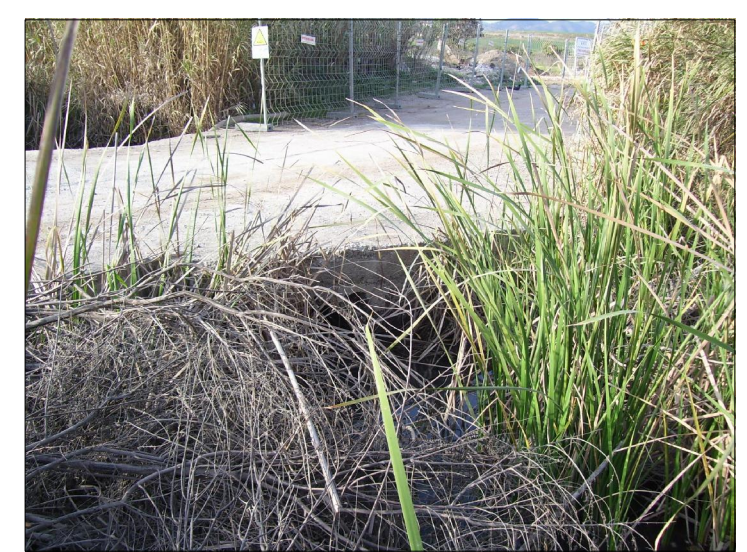
F4 Sección de obra de drenaje transversal aguas abajo
