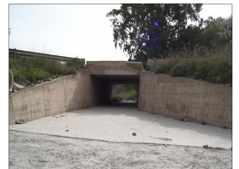
F4 Sección obra de drenaje transversal aguas arriba
