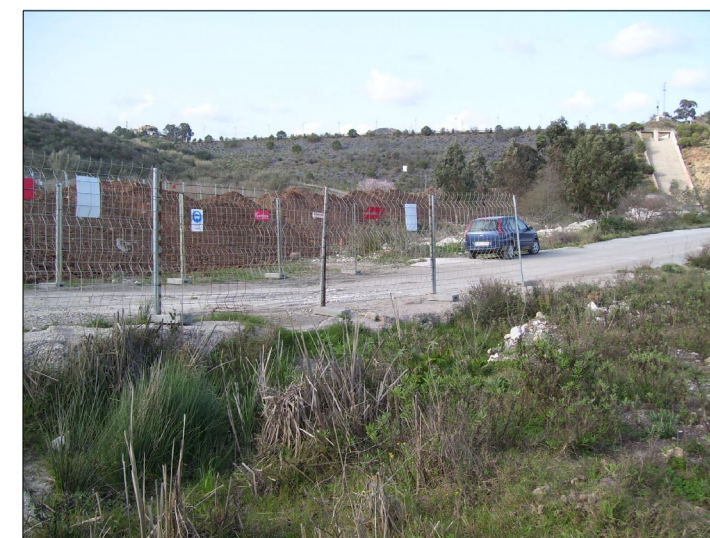
F3 Sección cauce aguas arriba (tramo en obra)
