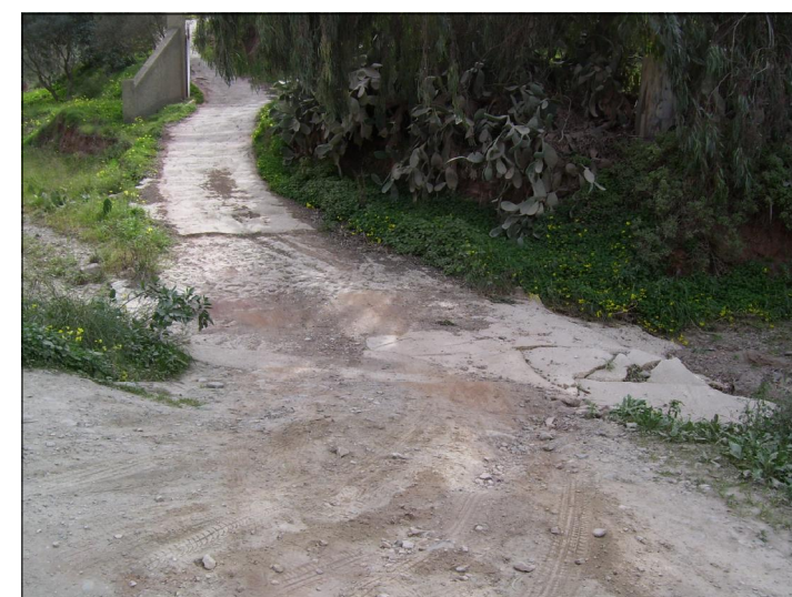
F3 Badén de hormigón
