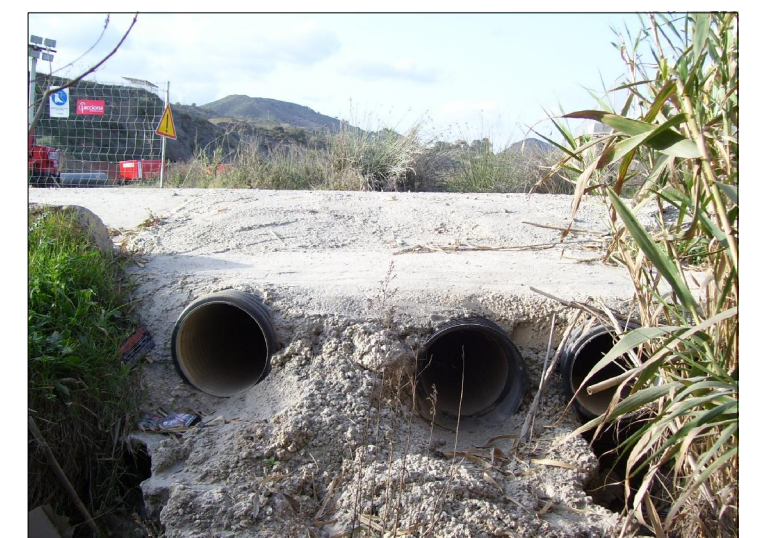
F4 Sección de obra de drenaje transversal aguas abajo
